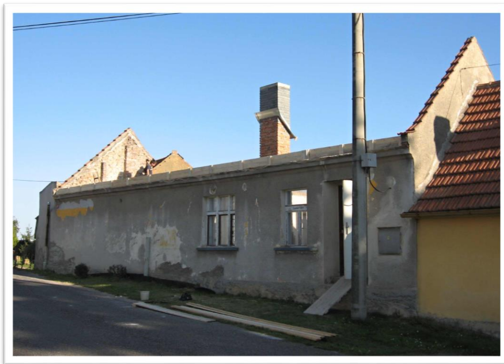
Přestavba domu č. p. 38
